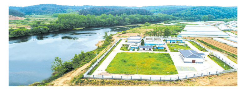
▲ 刚建成的安居镇污水处理厂
