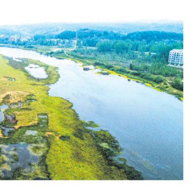
▲ 建设中的府河流域孔家堰段水生态综合治理工程
