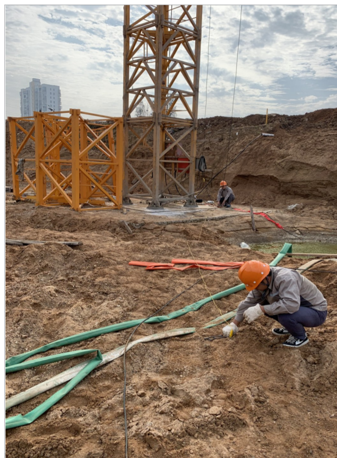
日前,湖北特检院随州分院对曾随文旅特色小镇——卓尔青铜古镇塔式起重机进行检验,确保施工安全。图为检验人员进行塔式起重机接地电阻检测。(随州日报通讯员 刘恒摄)
