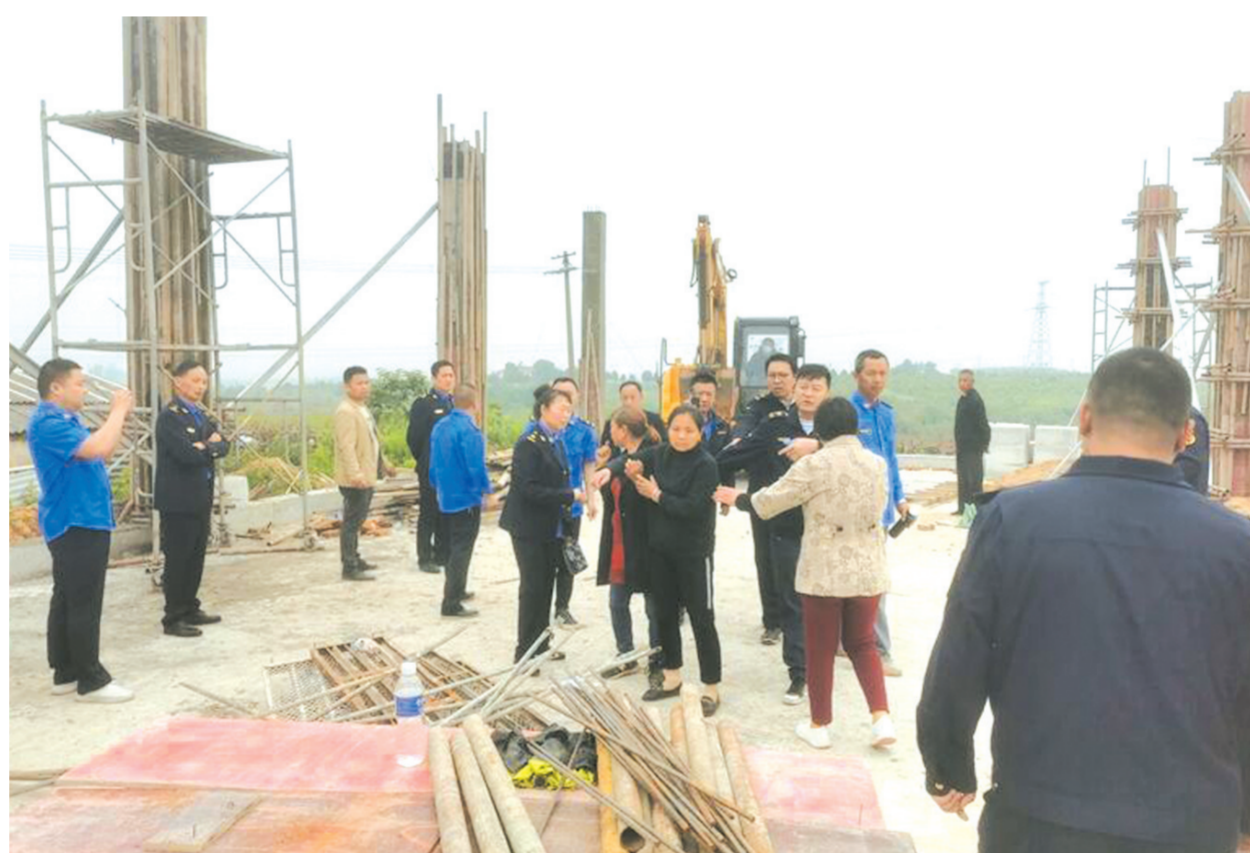
▲ 近日,广水市城郊街道办事处综合执法中心组织多部门联合执法,开展集中拆违行动,依法对油榨桥村一处非法占地实施拆除,违建面积约400平方米。(随州日报通讯员程焦摄)
