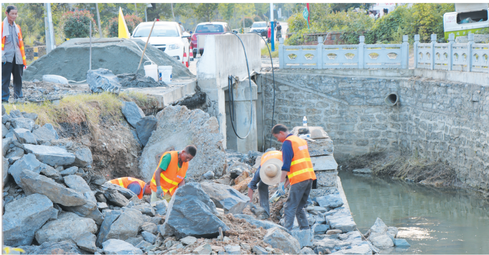
曾都区交通运输局抢抓好天气,组织对辖区内水毁公路设施摸排和修复,确保道路安全畅通。图为8月19日,工人正在对洛河镇张堰村水毁公路挡墙进行修复。
