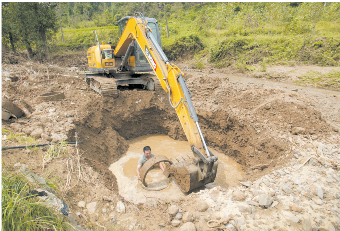
连日来,我市各地组织对水毁公路、桥梁、供电设施等进行修复,恢复生产,重建家园。图为随县柳林镇金桥村一组村民在河边挖井,保障生活用水。
