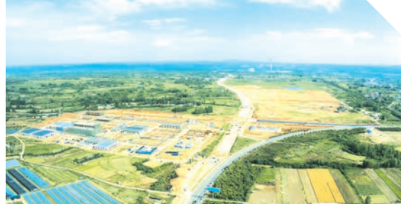
▲ 青春化工产业园
