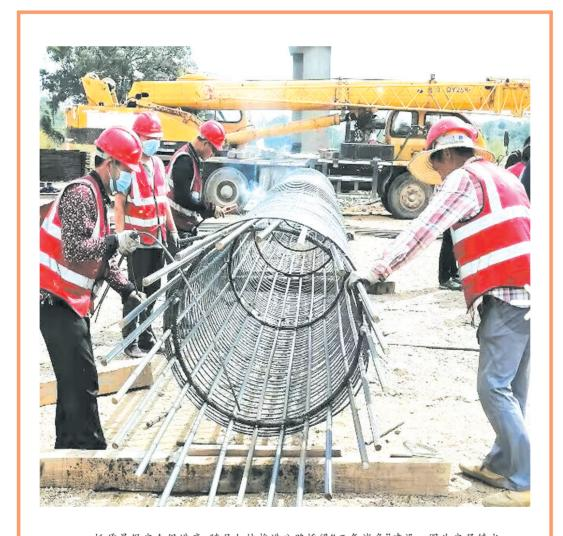
抓质量保安全促进度,随县加快推进公路桥梁"三年消危"建设。图为安居镇水厂桥工地现场,工人们正在进行桩基钢筋笼绑扎、焊接。
