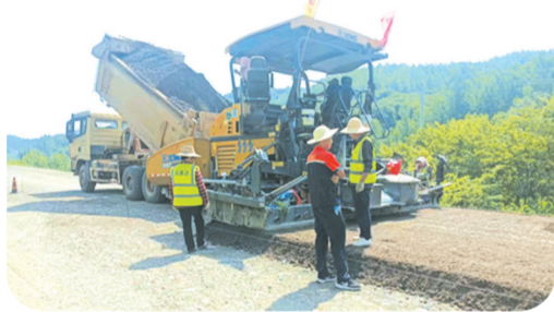
G240 柳林至周家湾公路施工现场
