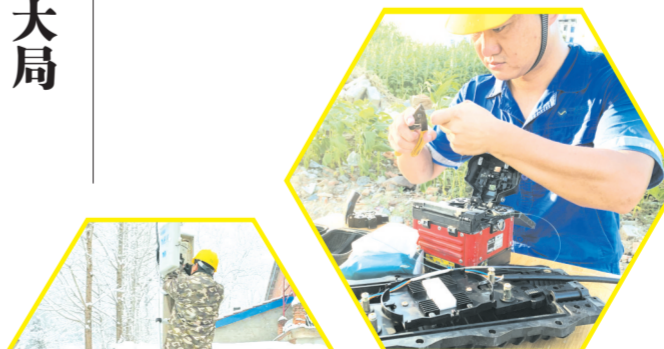
▲ 中移铁通曾都工作站徐师傅,顶着近40度高温支援洛阳宽带故障抢修
