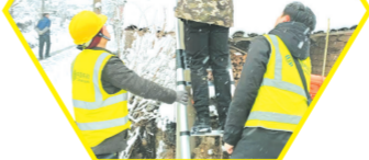
▲ 浙河十岗雪天宽带故障抢修
