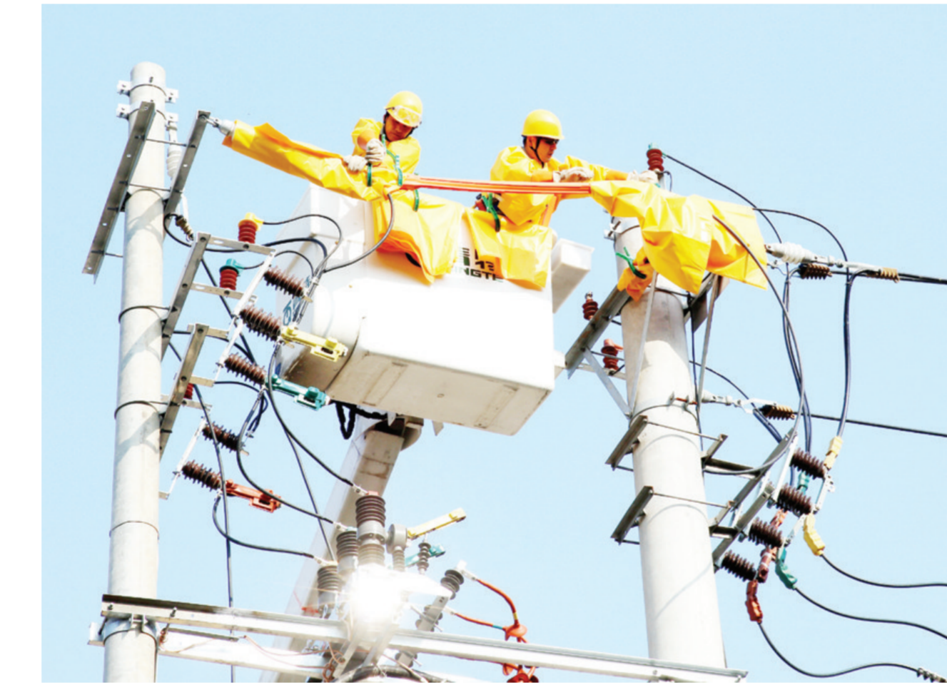
11月10日,国网广水市供电公司不停电作业班在10千伏蒋林线,对清华府二期新建台区进行带电搭火作业,及时为新建小区送电,保障住宅建设项目用电需求。(随州日报特约记者程淇、通讯员李紫娅摄)
