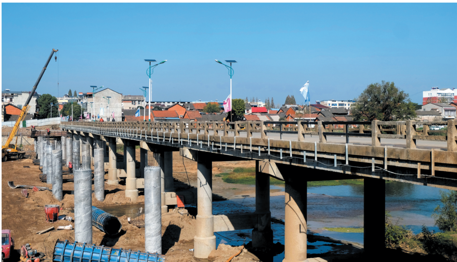
11月23日,位于随县安居镇安南山的安南山大桥正在加紧建设中。这座桥全长156米,宽7.5米,总投资537万元,于今年10月开工建设,建成后安南山村周边3个村和均川镇近万群众从中受益,出行更加方便。
