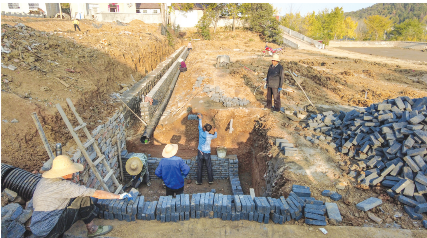
曾都区洛阳镇九口堰村以办好群众身边事,提升幸福感为目标,探索美好环境与幸福生活共同缔造路径。图为该村2组村民正在自己动手兴建当家堰污水处理池。(随州日报全媒体记者李文军摄)
