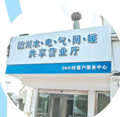
▲ 打造先行示范区 随州“水、电、气、网、暖”共享营业厅
