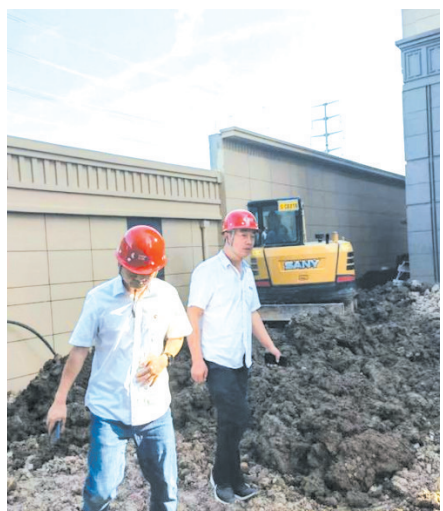
▲ 施工现场安全督察检查
