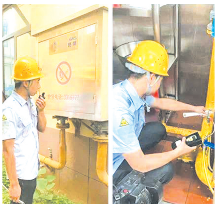
▲ 燃气设施定期维护检查
