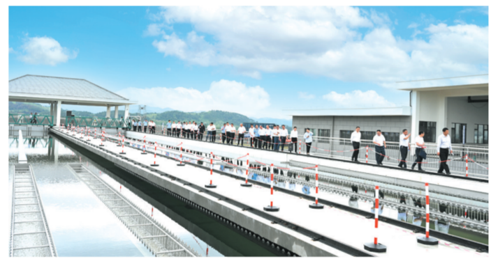
▲ 参观广水市飞沙水厂折板絮凝平流沉淀池
