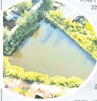
▲张家湾小河堰硬化
