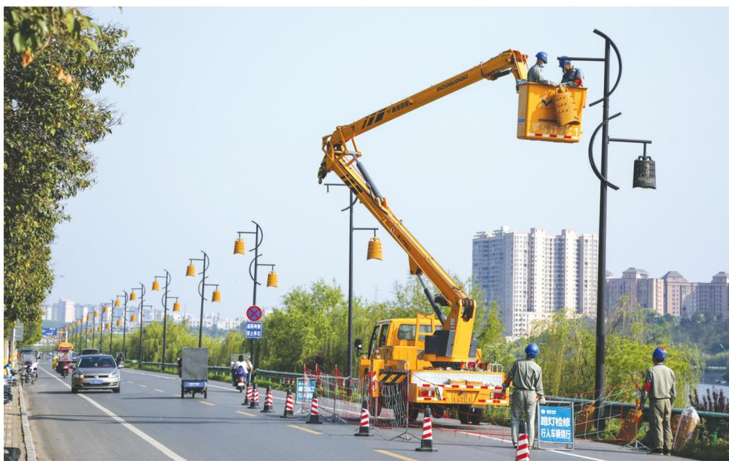
连日来,市路灯管理处利用晴好天气,对随州城区神农大道中段的115杆共计230盏路灯进行提档升级,保留编钟文化元素,更换新型节能灯具,增加弧形亮化灯带,进一步提升城市道路照明效果,以靓丽形象迎接寻根节。
