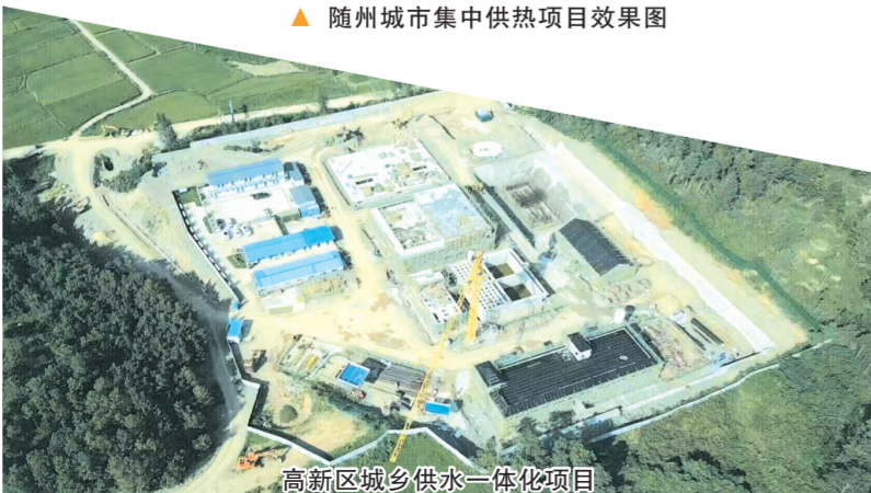
▲ 高新区城乡供水一体化项目
