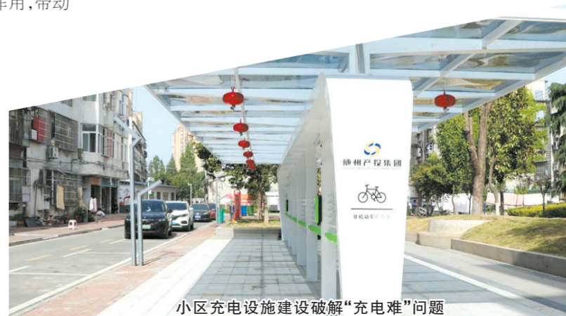
▲ 小区充电设施建设破解“充电难”问题
