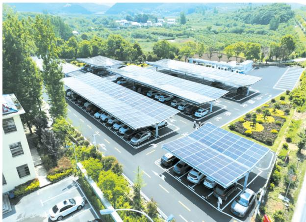
▲ 图为广水市十里街道观音村光储充一体化停车场,该停车场设计停车位132个,安装有V2G直流充电桩8台。
