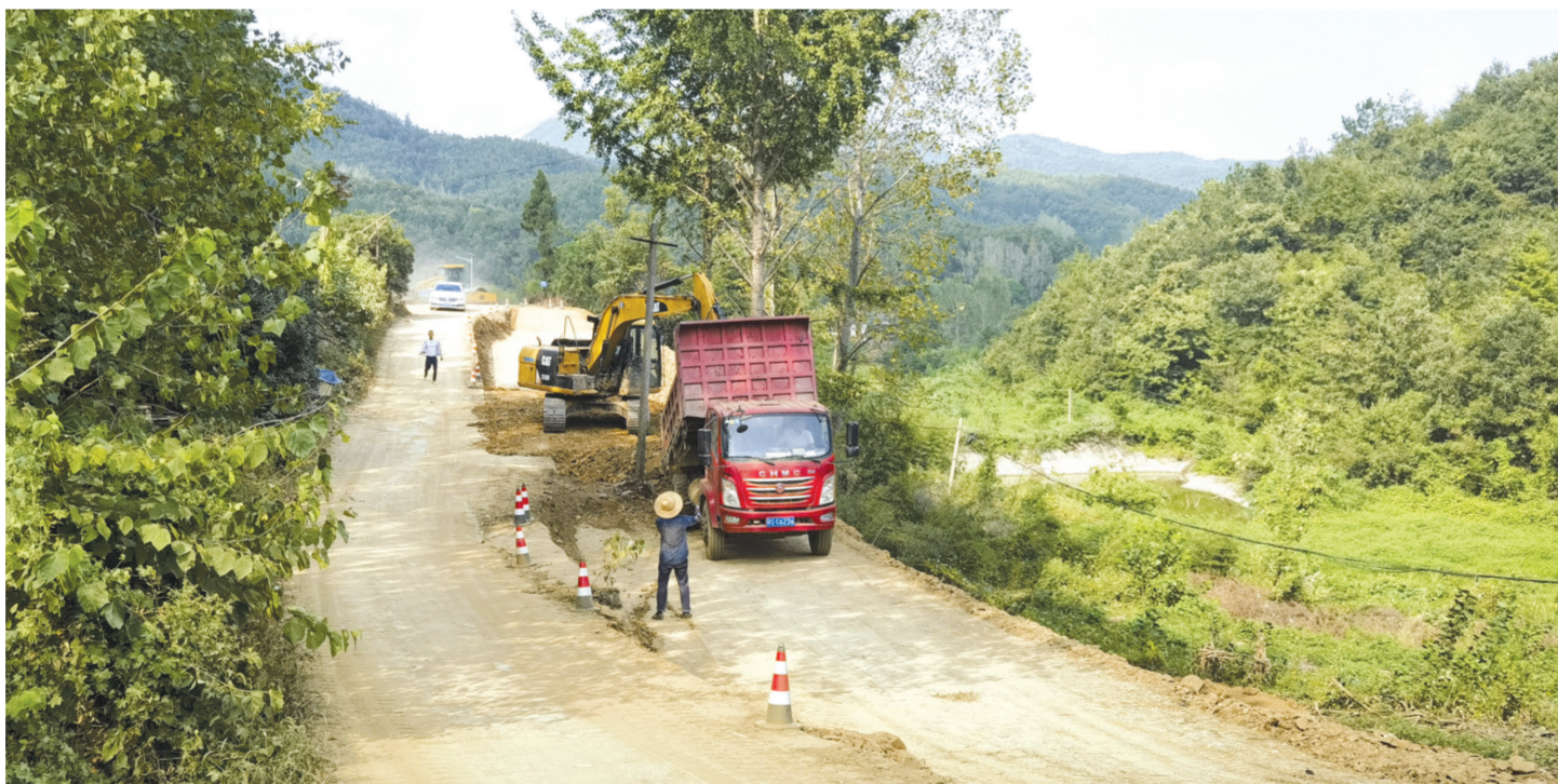
2023年4月动工兴建的“均洪线”是连接随县均川镇和洪山镇的重要农村公路,全长39.4公里。该路是随县县域农村公路提档升级重点工程,此前4米宽的水泥路面升级为6米宽的沥青路面。目前,均川镇路段已建成通车,预计今年年底全线建成通车。图为9月4日,“均洪线”三里岗镇新集村路段建设现场。(随州日报全媒体记者李文军摄)
