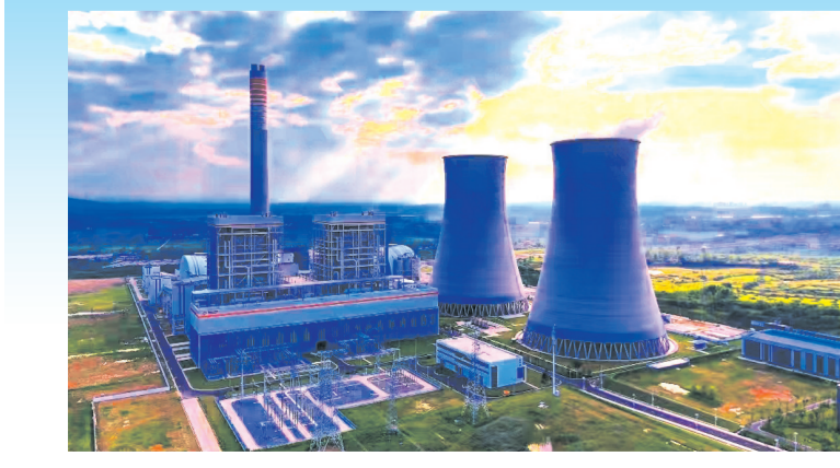
▲ 总投资49.9亿元的国能长源随州火电厂项目
