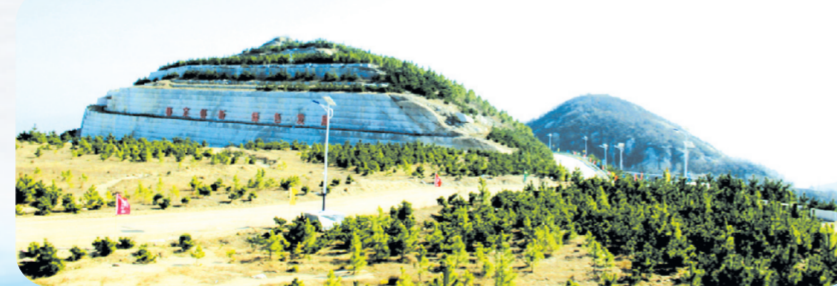
▲ 绿色矿山施工现场
