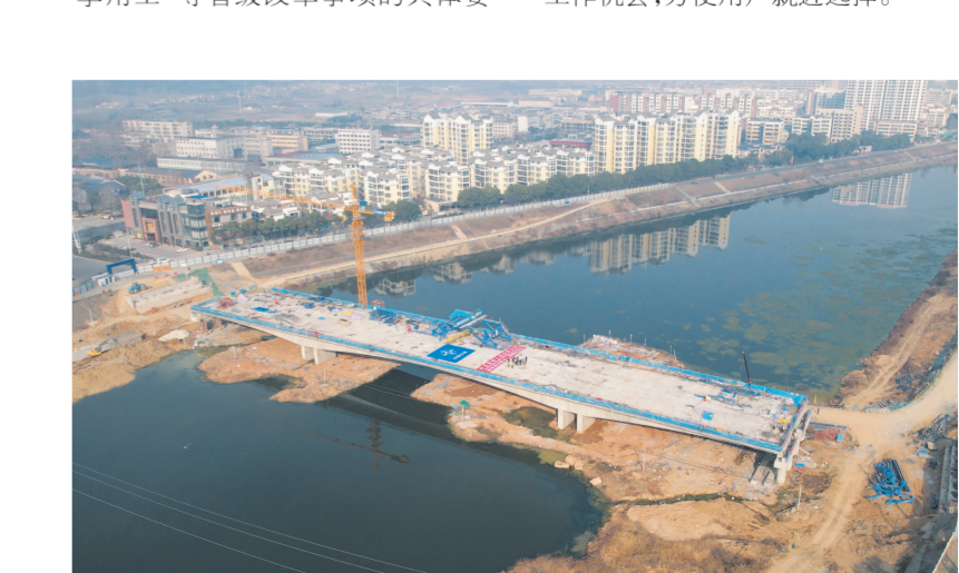
1月18日,随城灏水二桥拆除重建工程主桥顺利合龙,预计2025年寻根节前通车。(随州日报全媒体记者徐斌摄)
