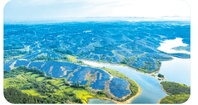
▲ 一片光伏板葡萄在广水的土地上
