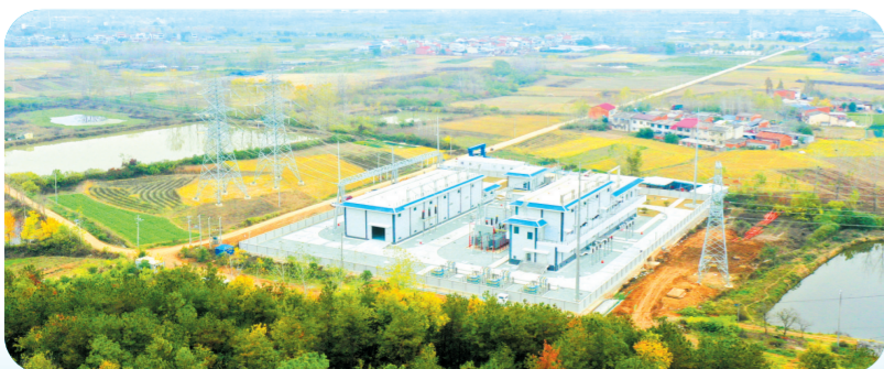
▲ 随州首座半户内GIS智能变电站——220千伏茶庵变电站顺利投运
