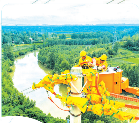
▲ 国网随县供电公司带电作业班成员在均川镇解河村进行带电检修
