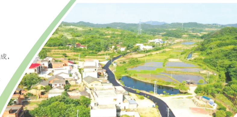
▲ 京桥至猫山村乡村道路建设一隅
