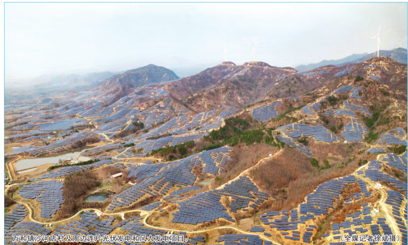
万和镇沙河店村及周边连片光伏发电和风力发电项目。
