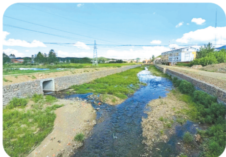
▲ 治理后的随县长岗店河长岗镇区段
