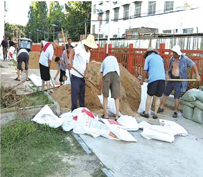
▲ 当前处于主汛期，广水市十里街道抓实各项风险防范措施，积极开展安全隐患排查整改。7月11日，十里社区组织防汛人员41人，备齐沙袋5000袋，对城区低洼易涝点十里西河辉盛小区临河200米河岸铺设油布和沙袋挡水围挡，防范因强降雨导致河道水位倒灌风险，筑牢群众安全防线。（通讯员 刘礼刚 蔡红霞摄）
