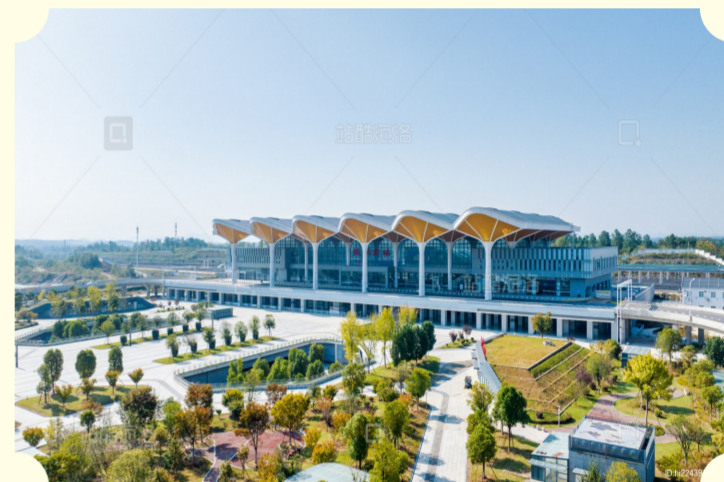
高铁随州南站
